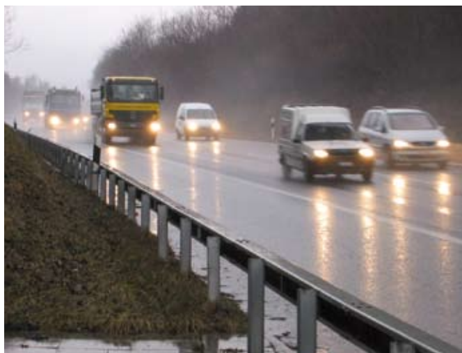
Abwasser von stark befahrenen Strassen soll nicht mehr ungeklärt in die Gewässer gelangen.
