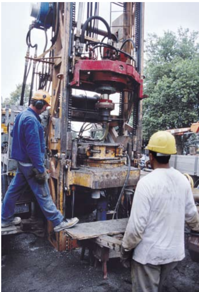
Grundwasserbohrung im Urnerland. In der Infrastruktur der Wasserwerke steckt ein Milliardenvermögen.
