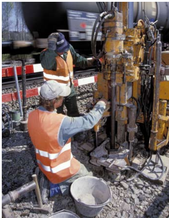
Erkundung eines belasteten Standorts durch die SBB.
