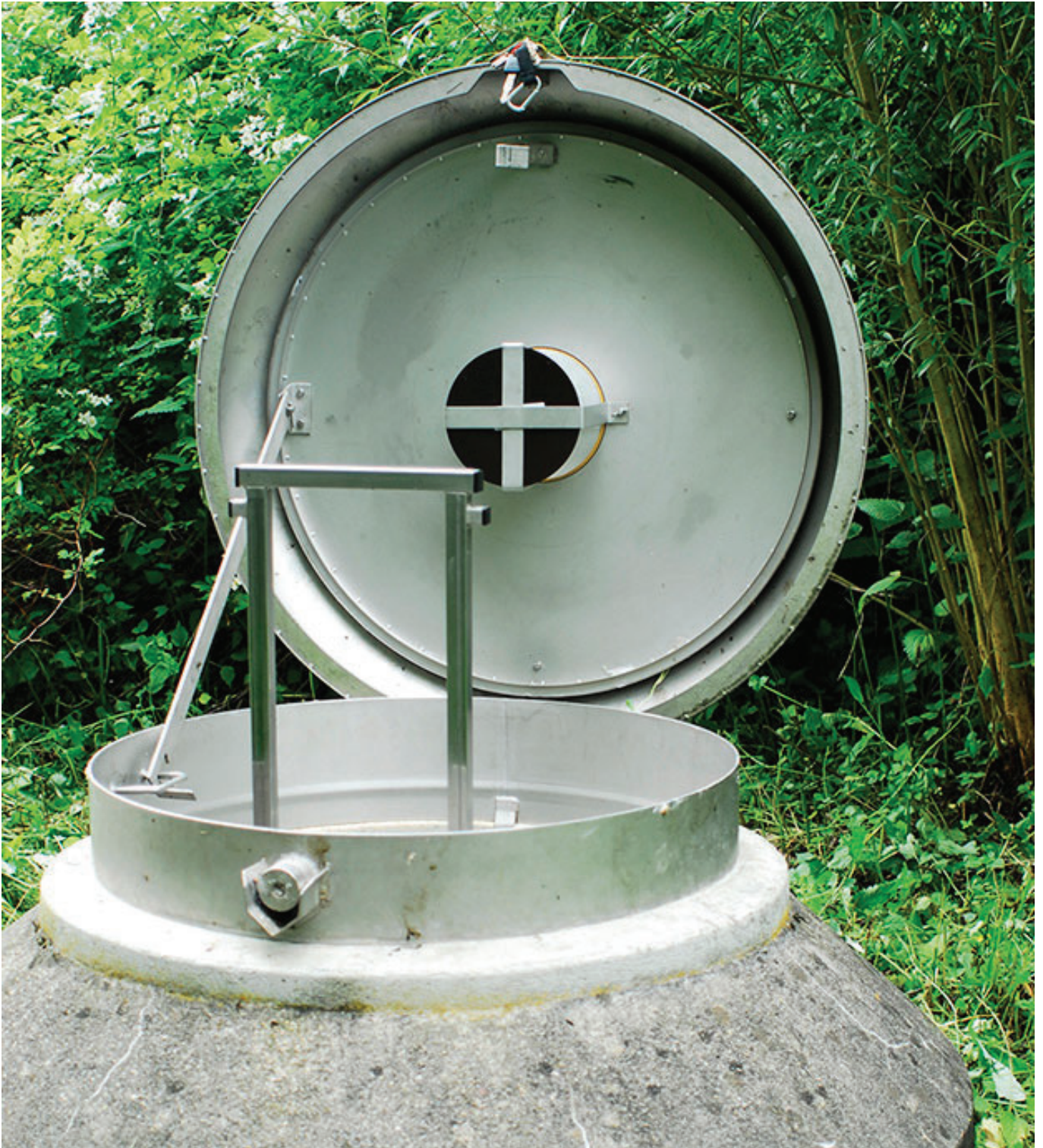
Einstieg in die Grundwasserfassung Böschenbach, Neckertal
