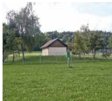
Die Trinkwasserfassung bei Gossau ist mit einem Zaun geschützt. In der Wiese davor steht eine hydrometrische Messstation zur ständigen Überwachung des Grundwasserspiegels.
