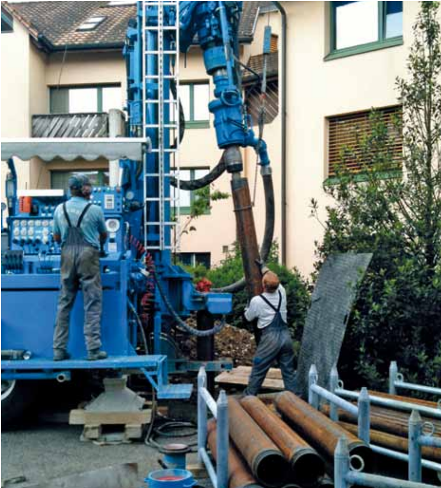
Bohrung für einen Grundwasser-Entnahmekosten zur Beheizung eines Wohnhauses.
