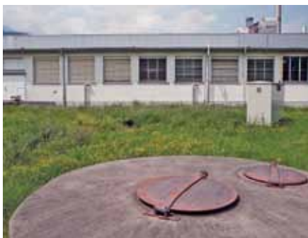
Grundwasserfassung (vorne im Bild) für die Brauchwassernutzung eines Industriebetriebs.
