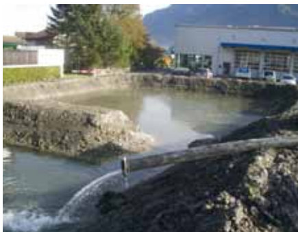
Baustelle: abgepumptes Grundwasser wird vorübergehend in künstlich angelegten Becken versickert.
