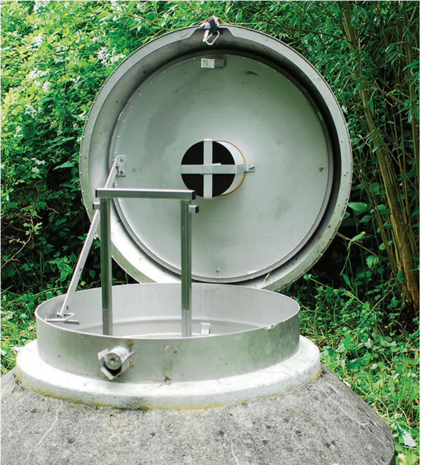
Einstieg in die Grundwasserfassung Böschenbach, Neckertal
