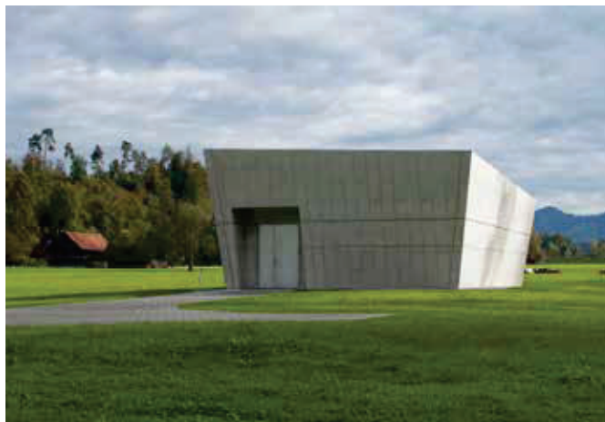
Grundwasserfassung Tägerswil der Wasserversorgung Rapperswil-Jona
