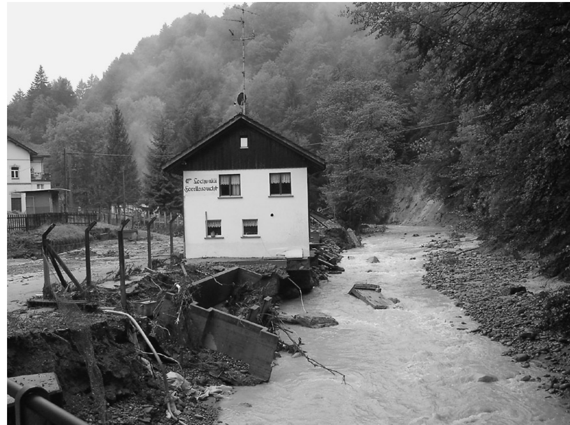
Hochwasser richten immer Schäden an – durch Freihaltung des Überflutungsraums lassen sich die Schäden begrenzen.
