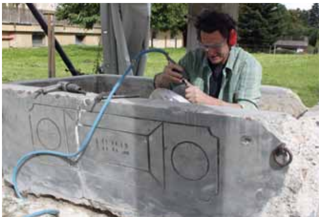
Niederhelfenschwil, Zuckenriet, früher Betonbrunnen von 1882, Tobias Hotz bei der Restaurierung. Foto Ernst Inauen, infowil plus, Zuckenriet.
