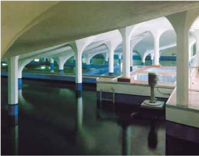
Goldach, Seewasserwerk, erbaut von Robert Maillart 1912, abgebrochen 2010. Aus: Billington, David P.: Robert Maillart und die Kunst des Stahlbetonbaus, Zürich/München 1990, S. 19.
