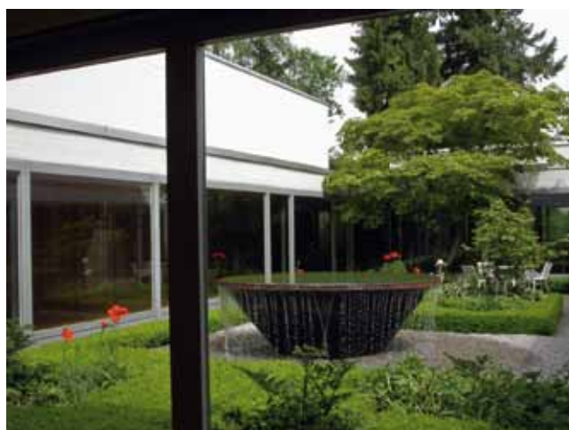
Rapperswil, evang. Kirchgemeindehaus, erbaut 1963 von Oscar Bitterli und dank einem neuen Inventar seit kurzem unter Schutz gestellt. Foto Kant. Denkmalpflege.
