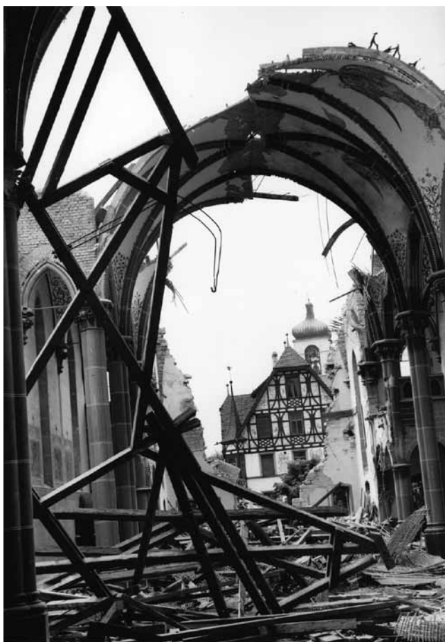
Gossau, Schutzengelkirche, Abbruch 1972. Foto Bernhard Anderes.
