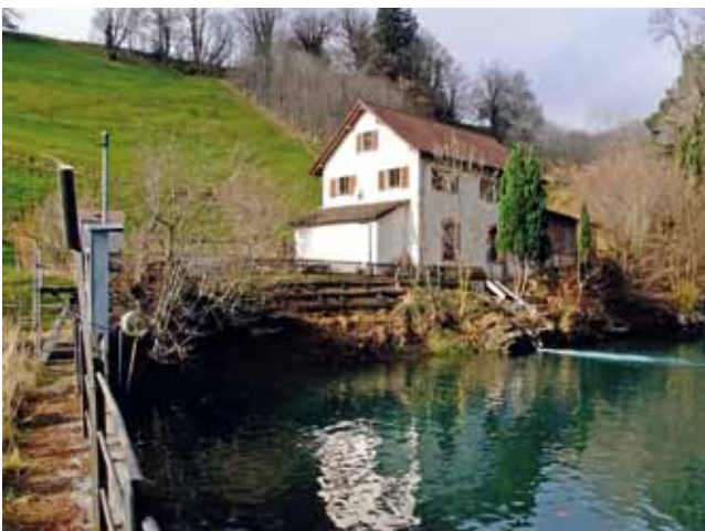
Wartau, Elektrizitätswerk Oberschan, ein neu entdeckter Zeuge der Industriekultur. Foto Kunstdenkmälerinventarisierung.
