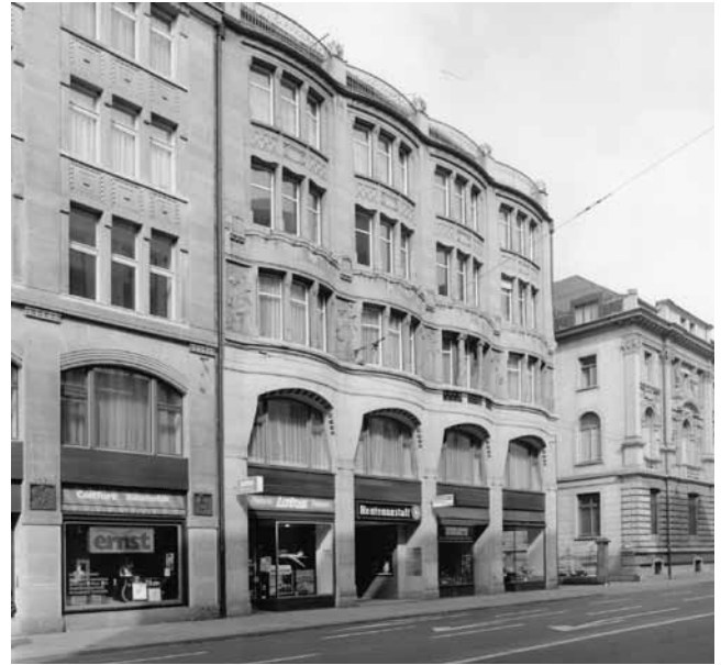
St.Gallen, Stickereigeschäftshaus Oceanic an der St.Leonhardstrasse, 1904–1906 erbaut von Pfleghard & Häfeli, Aufnahme 1985. Foto Bernhard Anderes.
