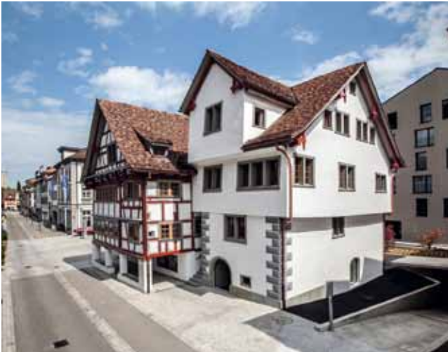
Rheineck, Krone und Laterne nach Jahren der Verlotterung frisch renoviert. Foto architekten : rlc ag, Rheineck.
