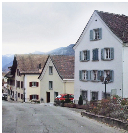
Das mittlere Haus gibt sich nur durch die modernen Fensterformen als neuer Anbau zu erkennen.
