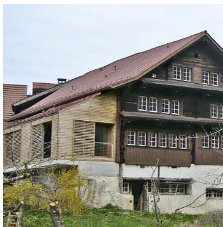
Der Anbau in moderner Gestaltung in Holz bleibt unter der Traufe und so eine neue, untergeordnete Zutat.
