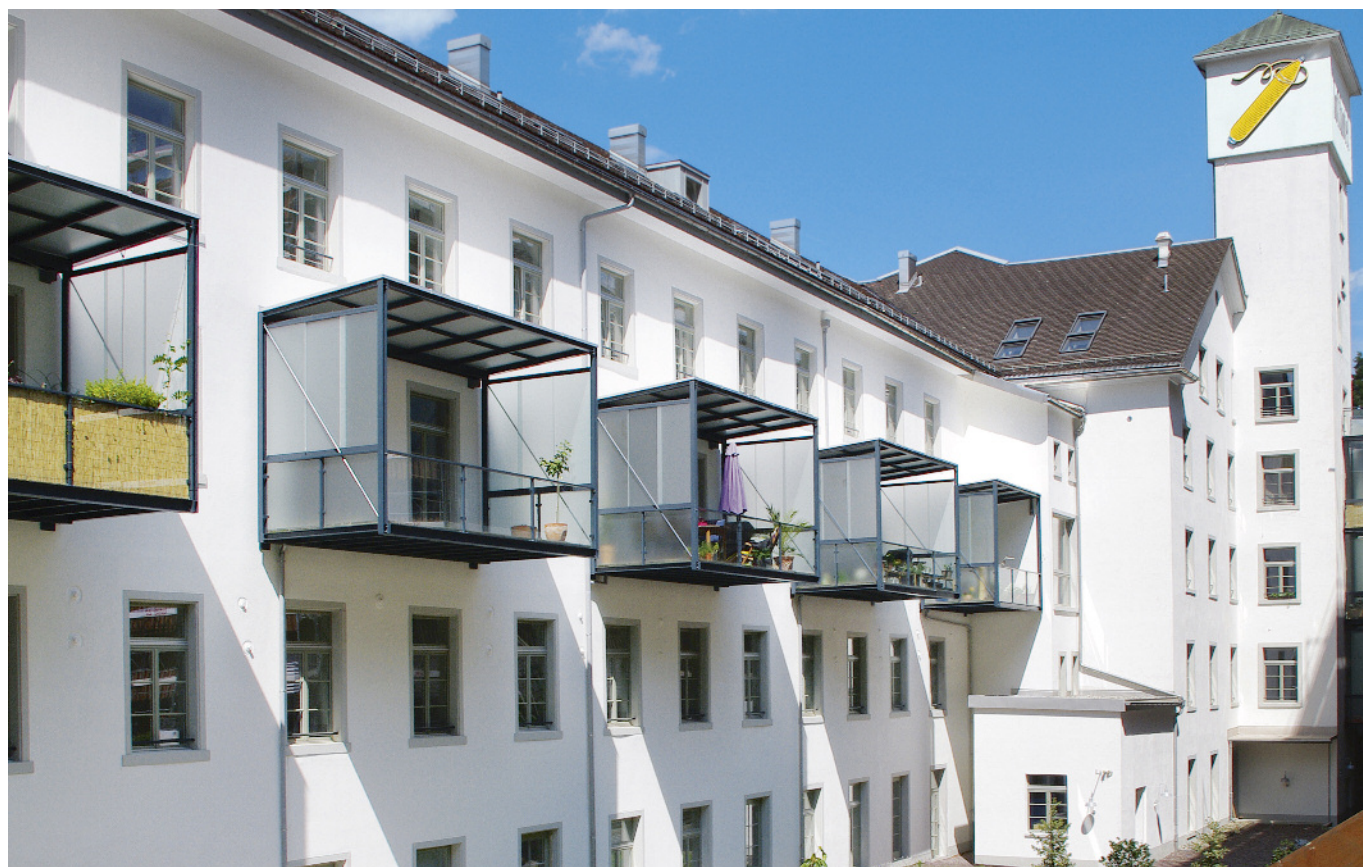
Grossformatige Industriebauten leben von der Einheitlichkeit der Fassade, Balkone sollen sparsam und in bewusster Ordnung eingefügt werden.
