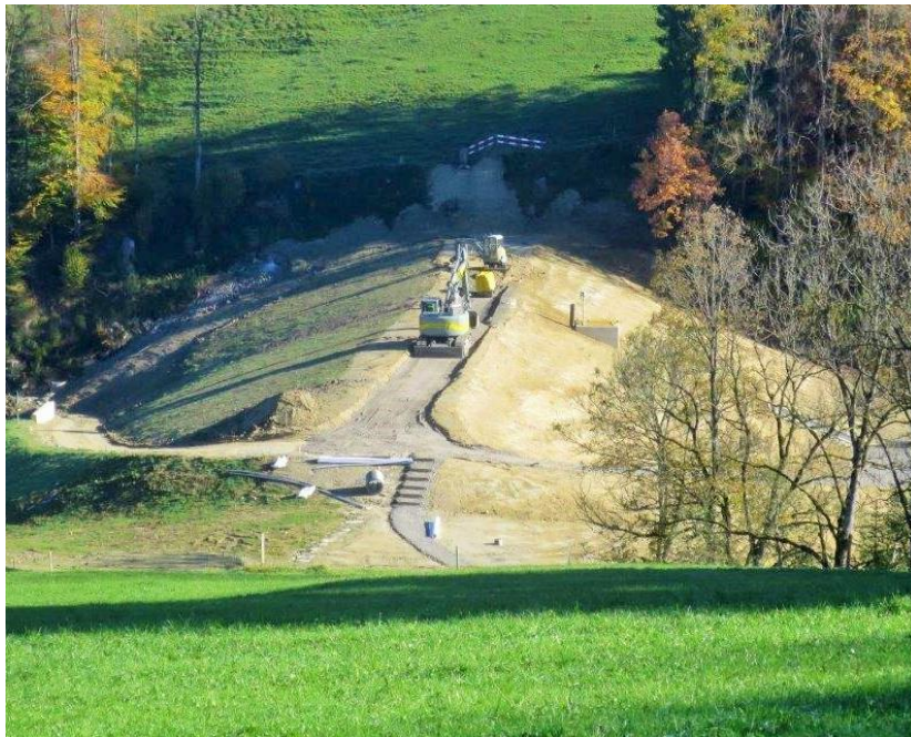
Rütiweiher im Bau
