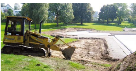
Abhumisierung des PCB-belasteten Bodens um ein Schwimmbad
