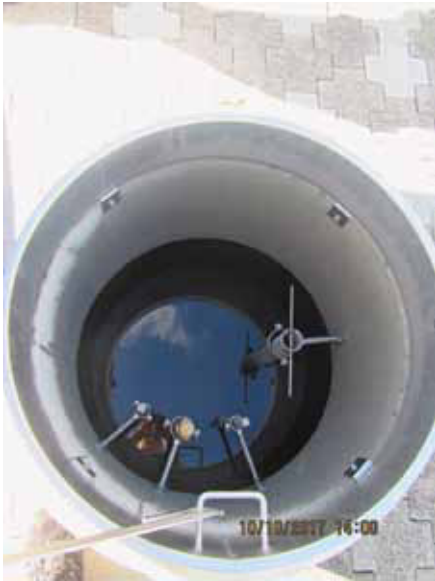
Neubau Wasserreservoir Alp Kamm, Gemeinde Rüthi.
