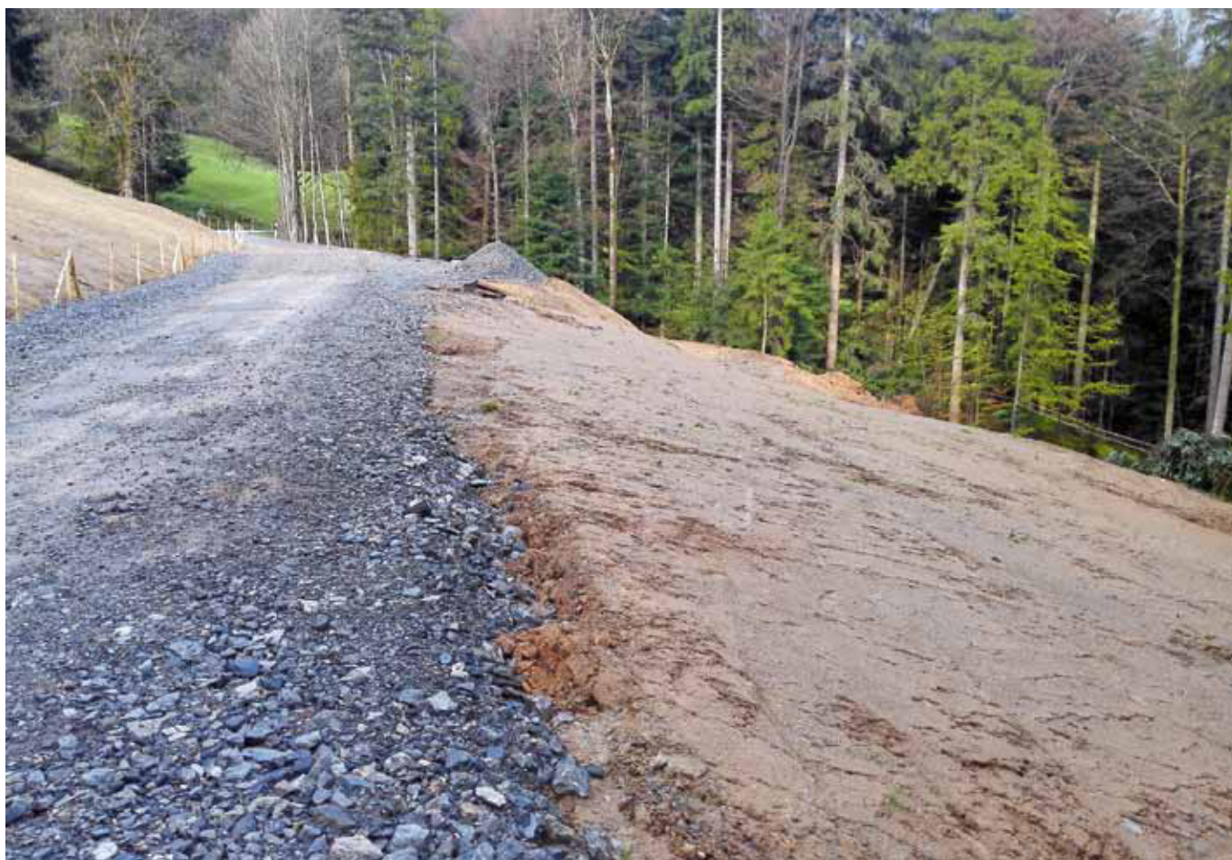
Wiederherstellung und Sicherung einer Strasse in Wattwil nach Unwetterschäden
