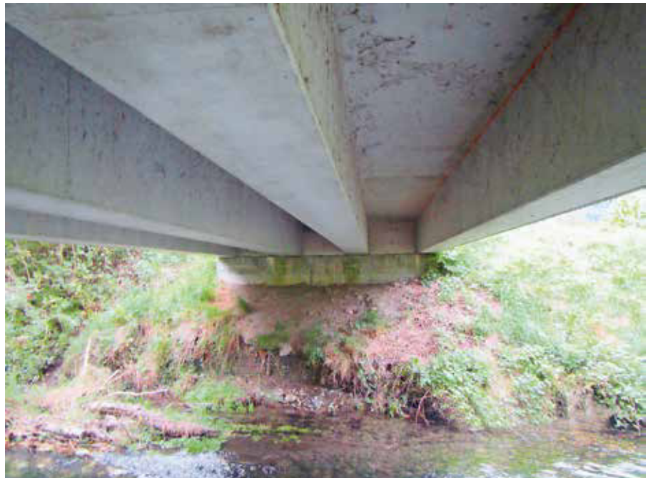
Unterhaltskontrolle an einer Brücke über den Werdenberger Binnenkanal
