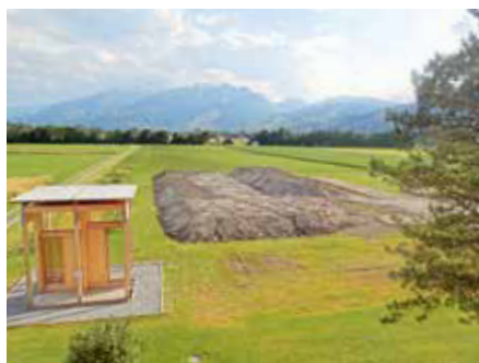
Fassadenmodell und sorgfältig angelegte Humus- und Aushubdepots der Baustelle in Salez
