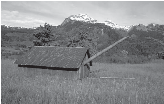
Die Turmkanone, eine von drei, befindet sich montiert auf der sogenannten «Abdeckung» des Festungswerks Magletsch (Bild: AFOM)
