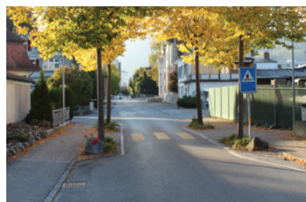
Beidseitige Einengung im Bereich einer Querungsstelle (Widnau)
