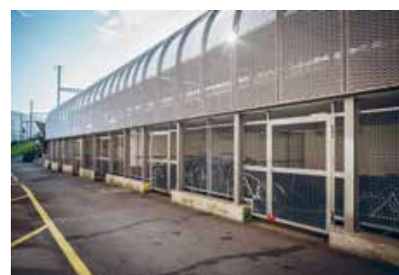
Beispiele von Velostationen und abschliessbaren Anlagen.
